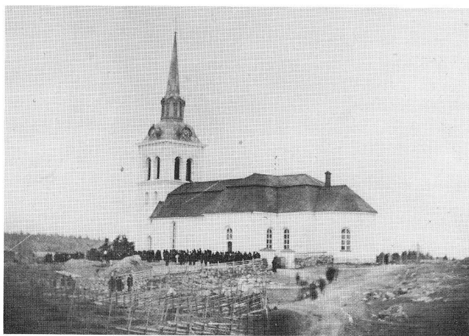
Gammalt foto av kyrkan, troligen från 1880-talet. Några träd hade som synes ännu inte planterats – det är kallt kring det stora begravningsföljet på kyrkogården. Man märker också, att den gamla bogårdsmuren ännu finns kvar. Den är tyvärr nu borta. Den stora stenen till vänster finns dock ännu på sin plats.
